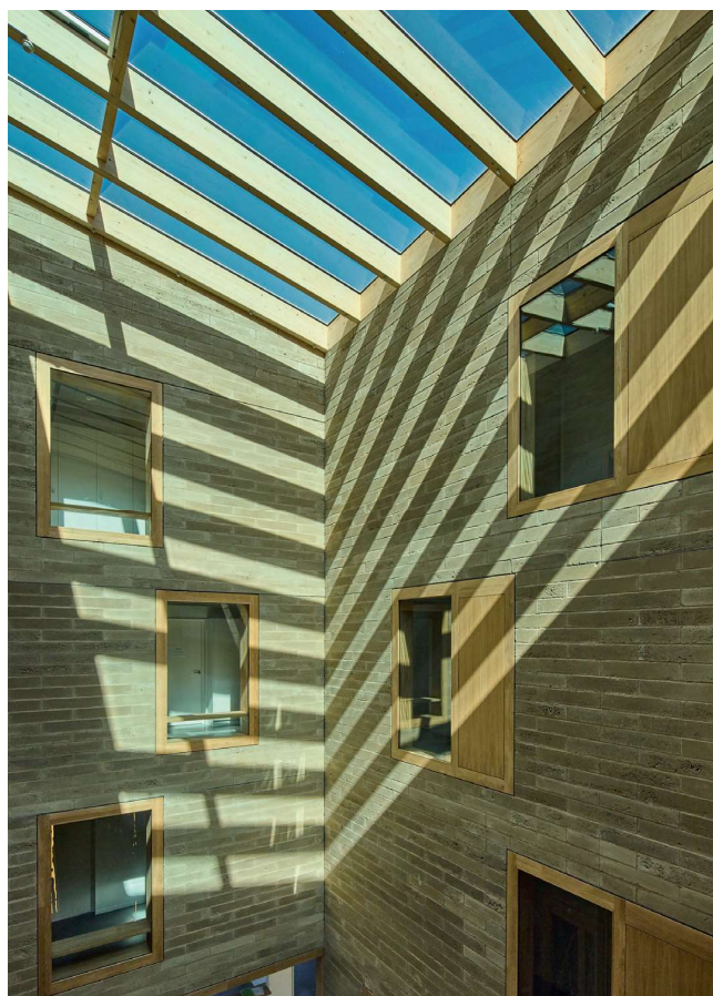
/ Les surfaces de travail s'organisent autour d'un noyau composé de deux patios (photo de gauche) qui, par effet de cheminée, tempèrent et ventilent les espaces intérieurs naturellement (photo de droite). Les murs en briques de terre crue (pisé) amènent un confort d'usage par leur aptitude à absorber et restituer l'humidité.
