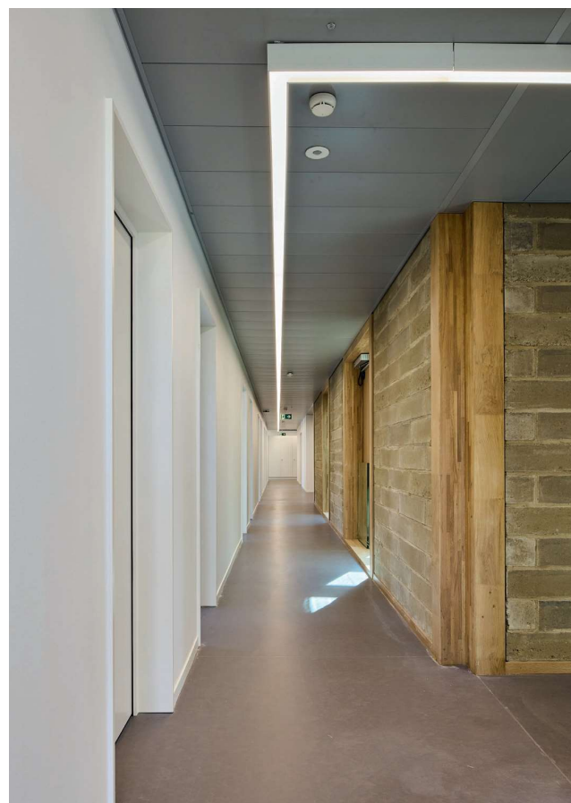
/ Les surfaces de travail s'organisent autour d'un noyau composé de deux patios (photo de gauche) qui, par effet de cheminée, tempèrent et ventilent les espaces intérieurs naturellement (photo de droite). Les murs en briques de terre crue (pisé) amènent un confort d'usage par leur aptitude à absorber et restituer l'humidité.
